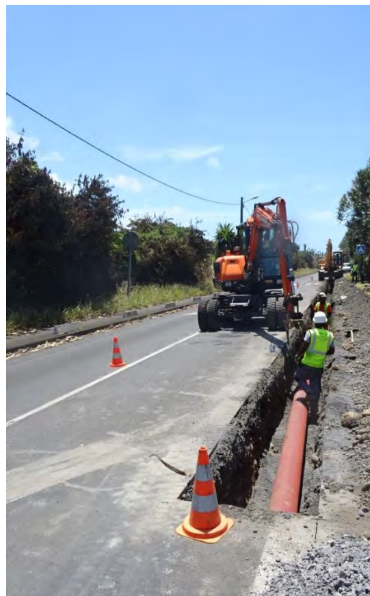
Figure 3 : Renouvellement de 750 ml de réseau d'assainissement sur la RD47 (Saint André)
