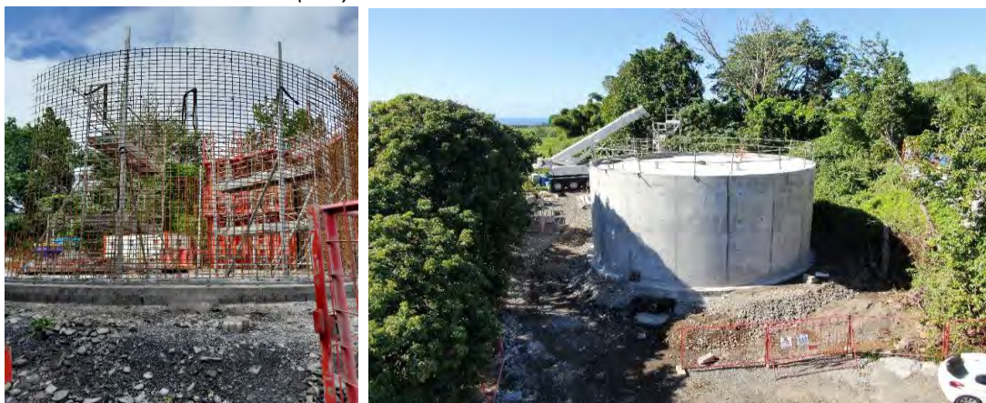
Figure 1 : Réservoir associé au Forage le DESERT
