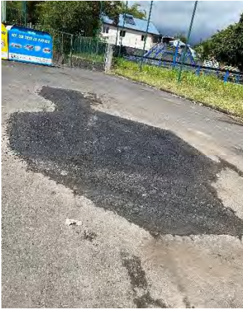
Figure 4 : Réfection plateforme basse et le bitume à l'avant de la déchèterie Sainte-Anne
