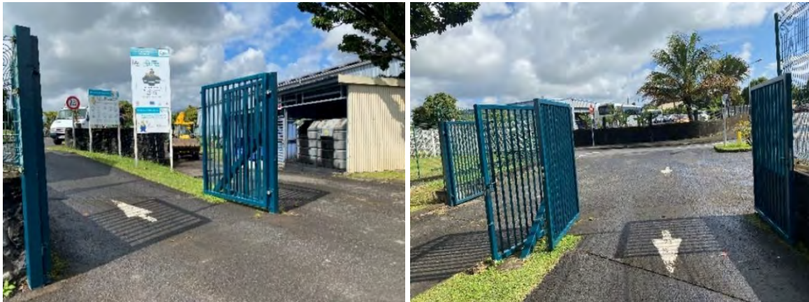
Figure 2 : Renouvellement des portails d'accès de Bras-Panon
